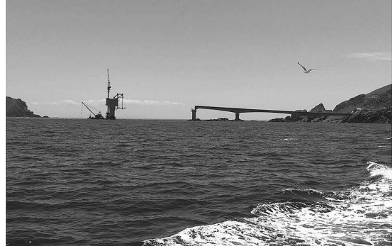
上甕島と下甕島を結ぶ橋梁工事
