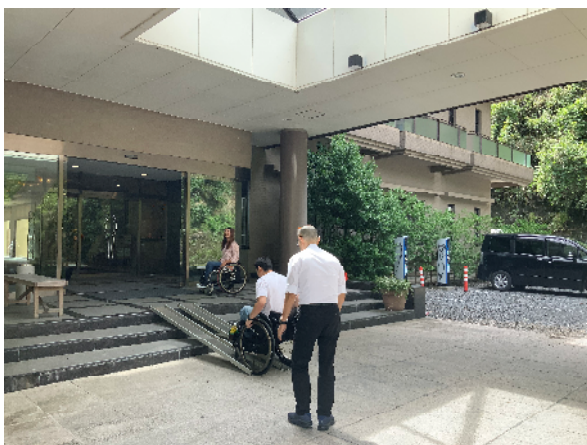
入口 簡易スロープ有
